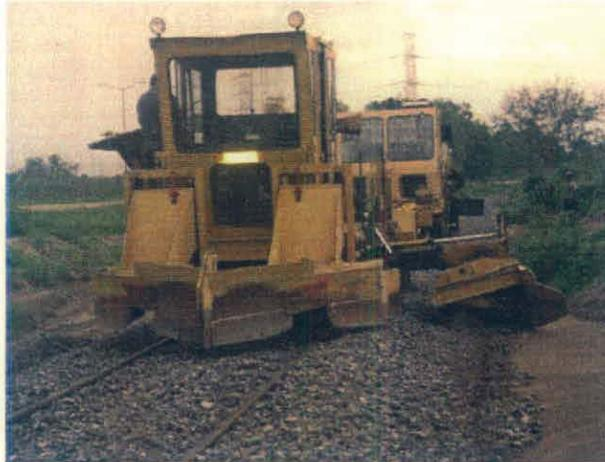
Independientemente del uso de la maquinaria para el regulado del balasto, se debe de considerar el perfilar y afinar a mano la vía en toda su superficie cuando sea necesario y limpiar la parte superior del durmiente, patín del riel y la fijación para que estas partes de estos elementos queden libres de balasto.
