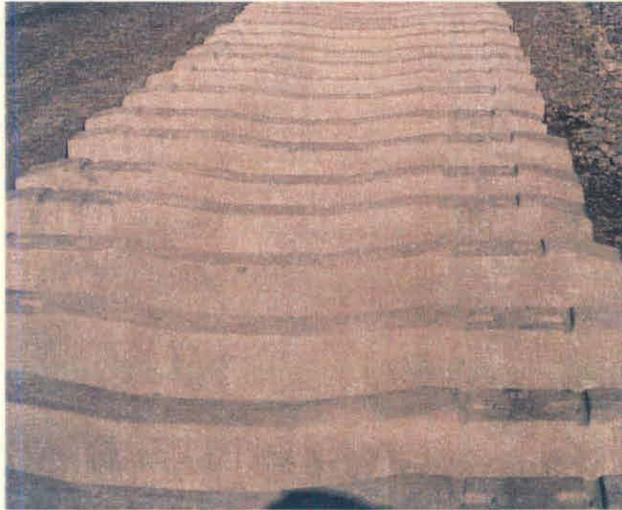
Los durmientes van espaciados a 60 cm de centro a centro entre si y perpendiculares al eje de proyecto y de los rieles.
