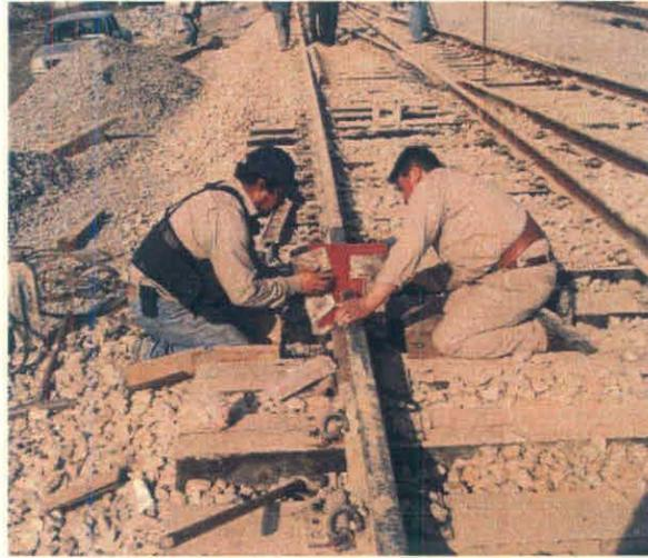
**Pre calentamiento:** El pre calentamiento se realiza durante 5 minutos para eliminar humedad residual de los moldes y aumentar la temperatura en los moldes y en las puntas de los rieles a soldar con temperaturas aproximadas de 700 grados centígrados. Las boquillas del soplete deben de estar a 50 mm. De altura del hongo de riel. Las presiones operables son; oxígeno 70 lbs/pulg.<sup>2</sup> y propano 10 lbs/pulg.<sup>2</sup> (Ver foto)
